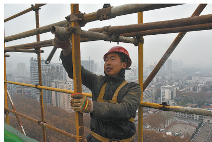
外架工李亮在高空作业
