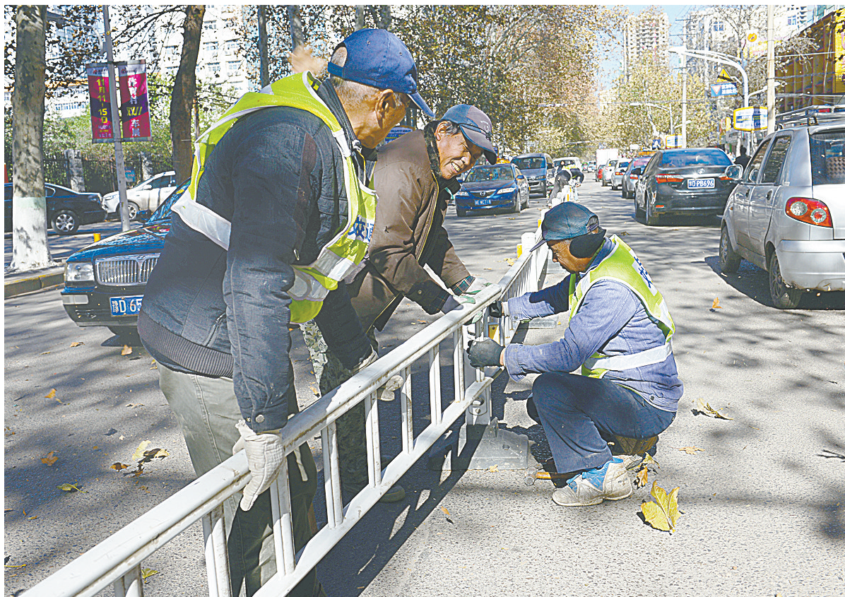
昨天上午,记者在市区开源路中段看到工程人员正在路中央安装崭新的护栏。为了规范开源路中段湛北路至园丁路之间的交通秩序,确保道路畅通,市交管部门在这里安装了护栏。 本报记者 禹舸 摄
