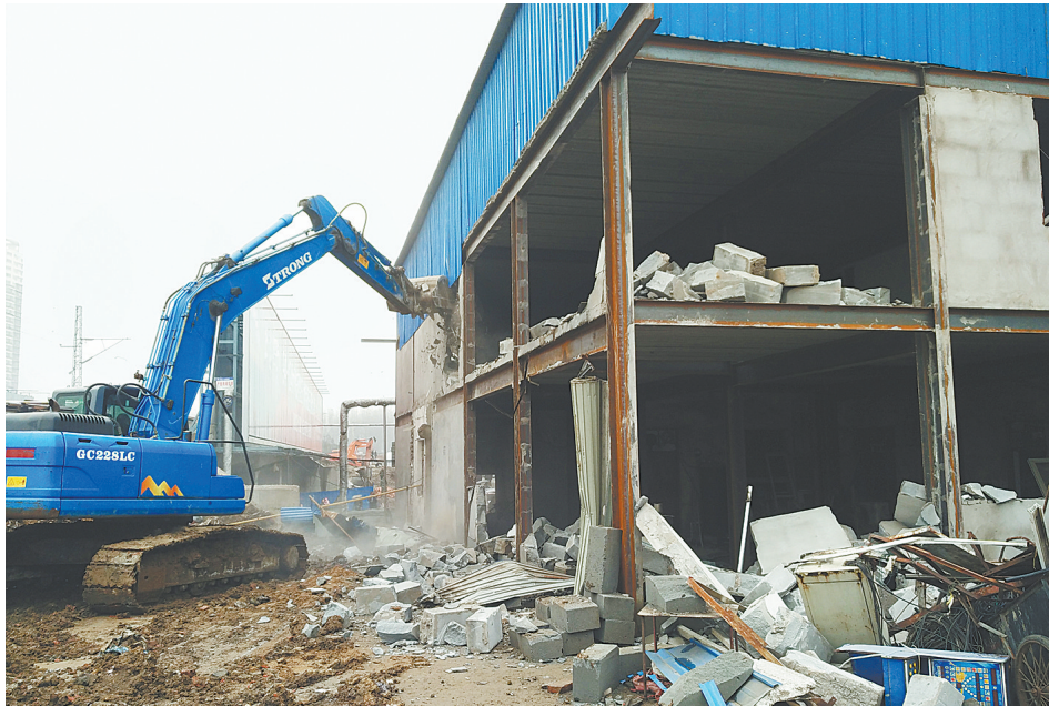
施工人员使用挖掘机拆除违建房屋
