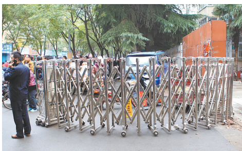
平顶山供电公司家属院的电动门弯曲变形
