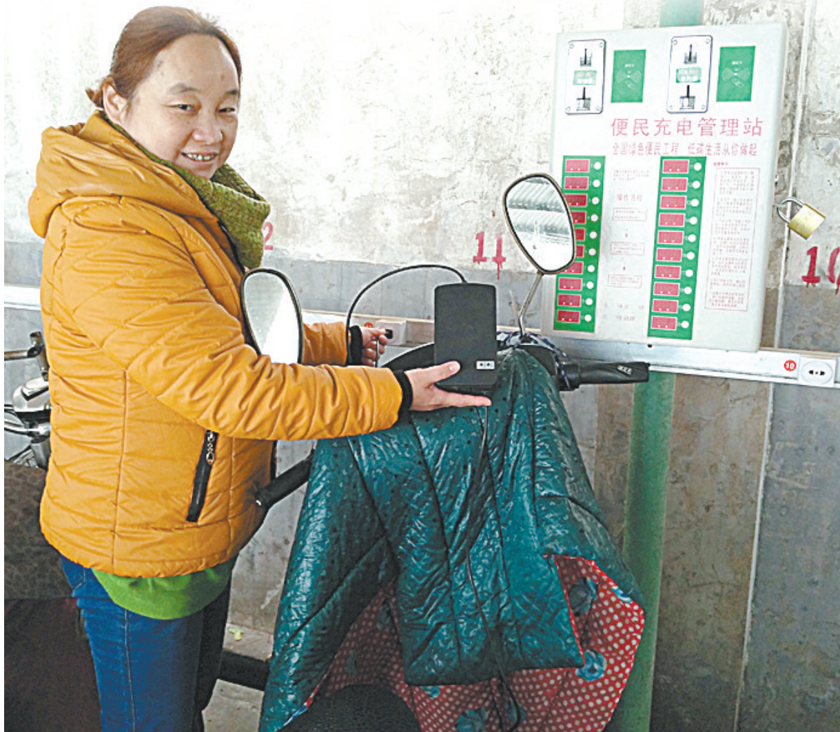
居民张女士投币两元为电动车充电8小时,正准备拔掉充电器的她说:“时间到了,设备就自己断电,用着放心。”
