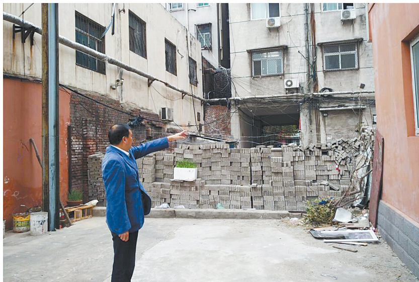
小区东大门被一道砖墙堵了起来
