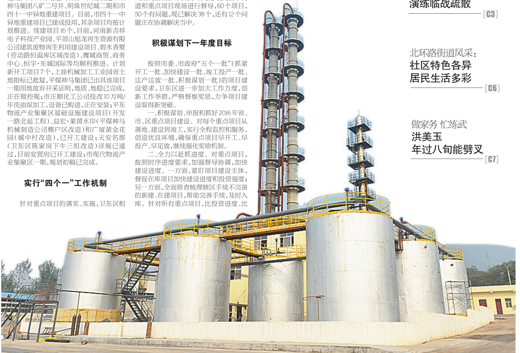
图为正顺化工有限公司新建的蒸馏塔。本报记者 禹舸 摄
