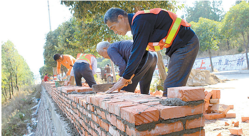
10月15日,施工人员在垒砌道路护栏。本报记者 李英平 摄
