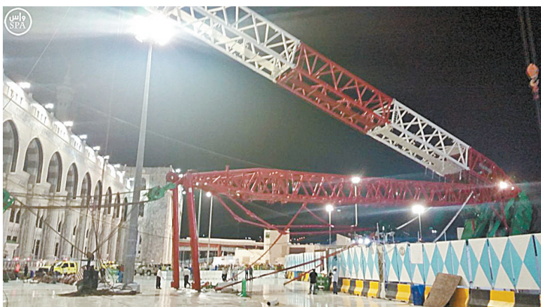
这是9月11日拍摄的发生塔吊倒塌事故的伊斯兰教圣地麦加大清真寺。沙特气象部门的人士说塔吊倒塌可能是风力太大所致。新华社/沙特通讯社
