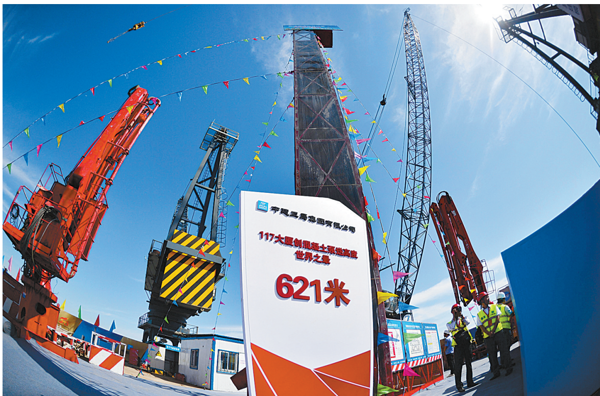
天津596.5米高117大厦封顶
