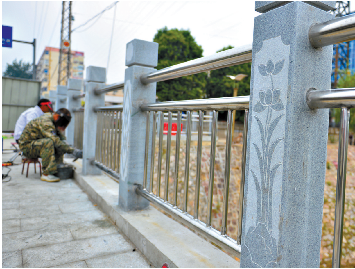
新华路湛河桥安装浮雕护栏
