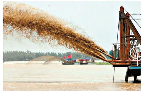
黄河调水调沙期间,扰沙船只在河南范县黄河段面进行人工扰沙清淤作业(资料照片)。
