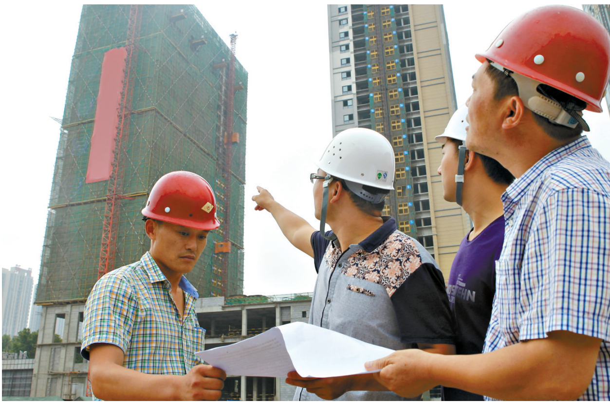
7月15日,在市区诚朴路北段一个建筑工地,卫东区住建局工作人员(左二、左三)会同工地管理人员,查看在建高层安全密目网安装使用情况。本报记者 李英平 摄
