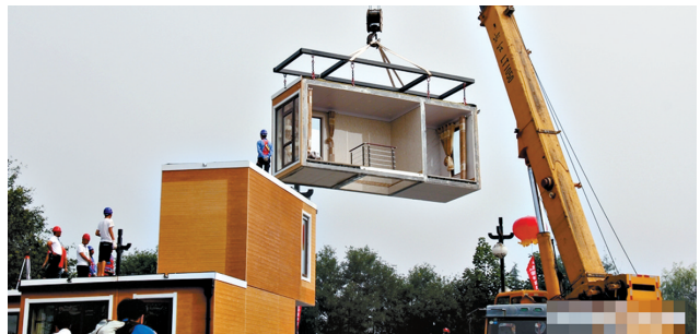
装配施工现场
