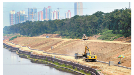
昨天,市区凌云路以西的湛河治理工程现场,施工机械在平整亲水平台基础。美观、整洁的景观初现。 本报记者 李英平 摄
