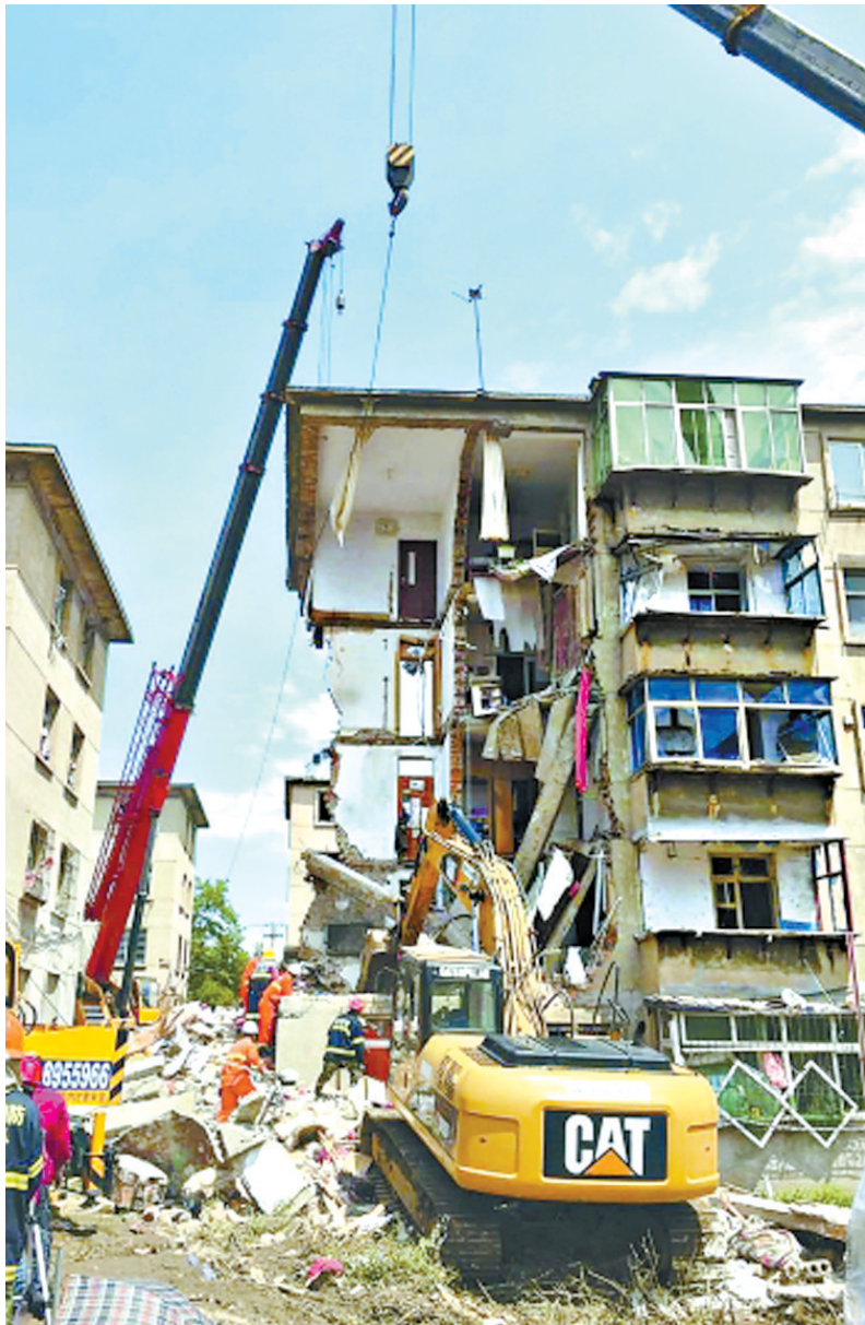
居民楼西侧外墙半扇楼体崩塌
