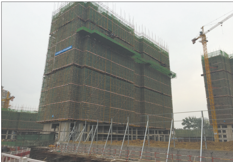
名门世家(绢纺厂原址)工程进度
