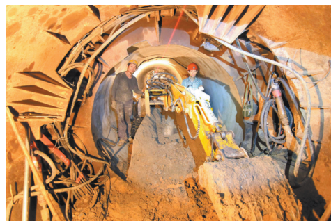
扒渣机在狭小的空间里成为顶管施工的利器。
