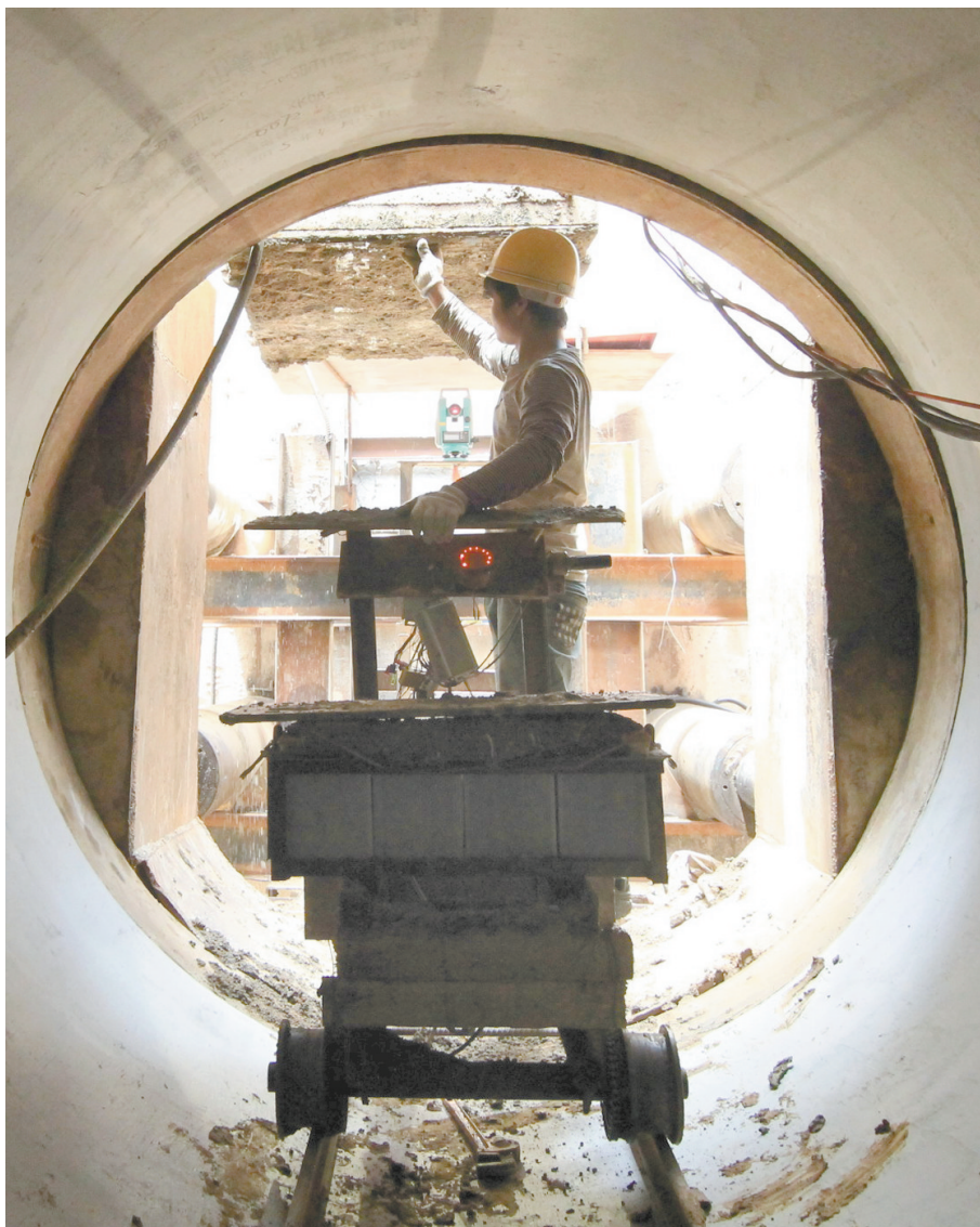
每项进一节长度为2.5米排污管道,平均需要6个小时。工人每天要挖出60多吨的土。
