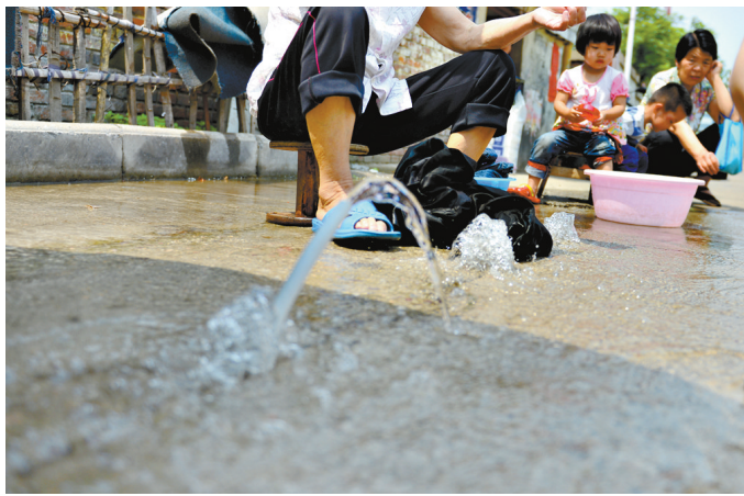
昨天,市民在自来水涌出的路面处洗衣。 本报记者 禹舸 摄
