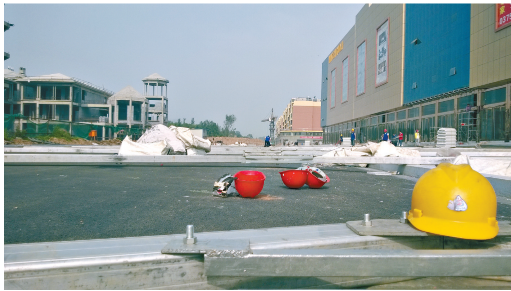
博览会展棚搭建现场(葛生华摄)
