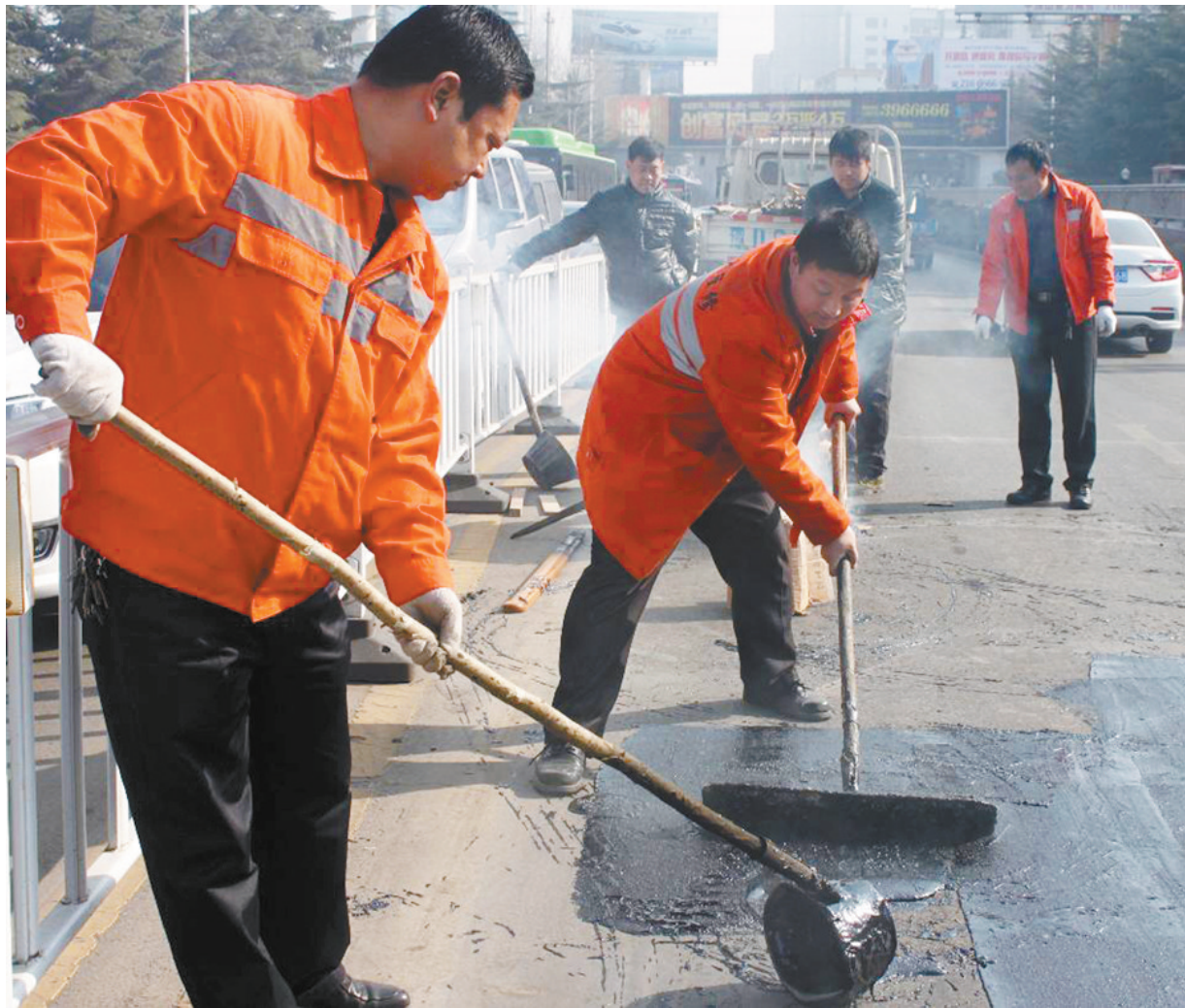
路面破损及时修复
