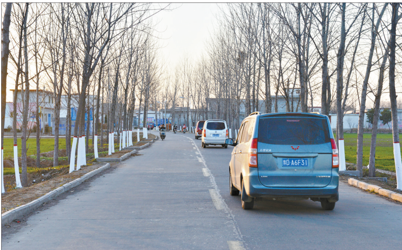
宝丰县张八桥镇境内新修的公路极大地方便了附近群众的生活
