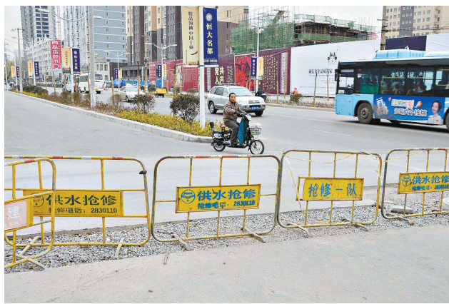
市区南环路西段非机动车道上,施工护栏横阻道路。
