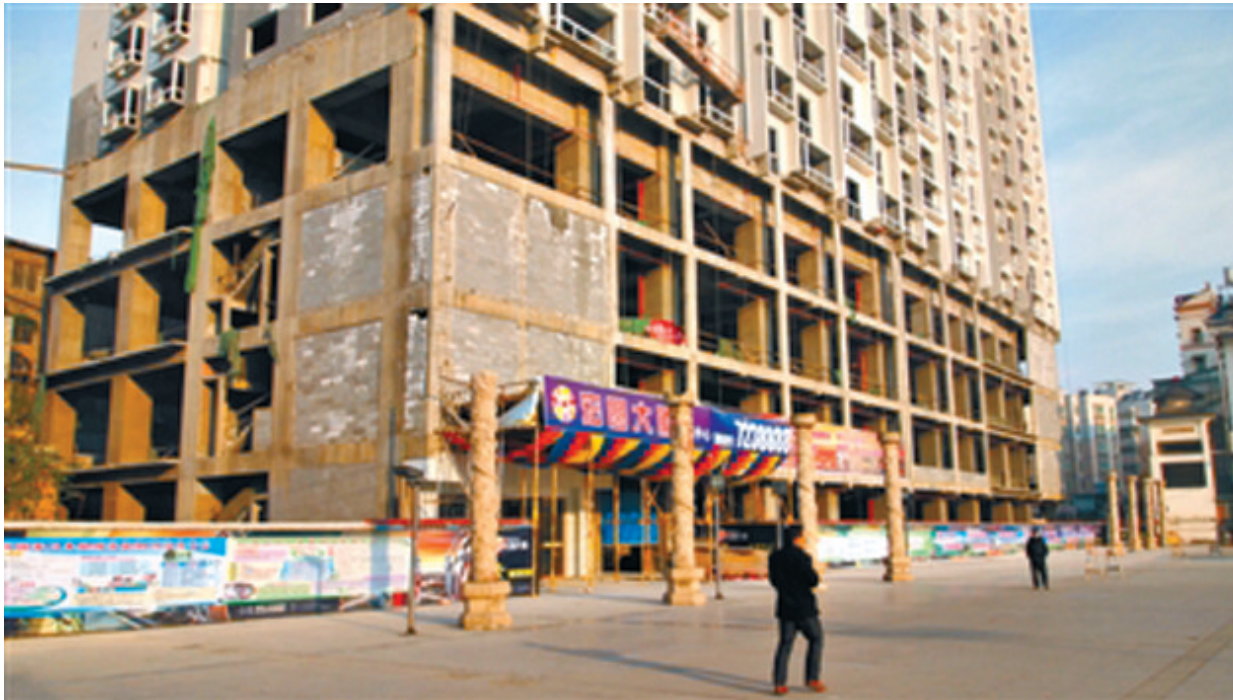
图为贵州省金沙县鼓韵广场宏圆大厦,正是这栋楼引发全国首例检察机关针对环保部门的行政公益诉讼。
