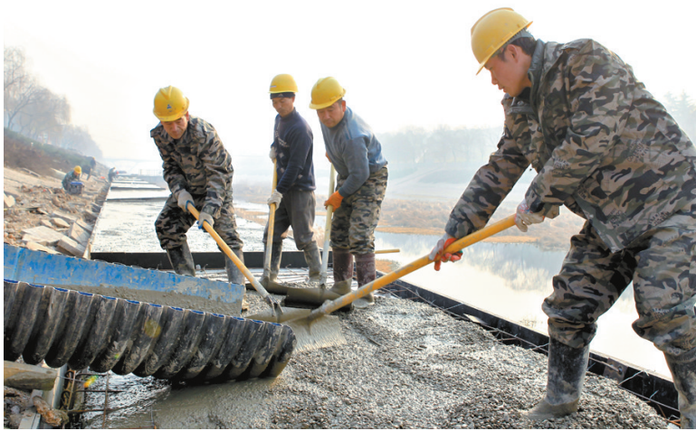
昨日,在市区光明路湛河桥东侧,施工人员进行北岸排污暗涵盖板顶部浇筑。当日,记者从担负着市区文园路至众福桥湛河治理任务的施工人员处了解到,元旦假期期间,施工人员放弃了休息,坚持奋战在工地。从1月1日至3日,完成北岸排污暗涵盖板顶部浇筑500余米,为提前转入盖板顶部人行方砖铺砌赢得了时间。
