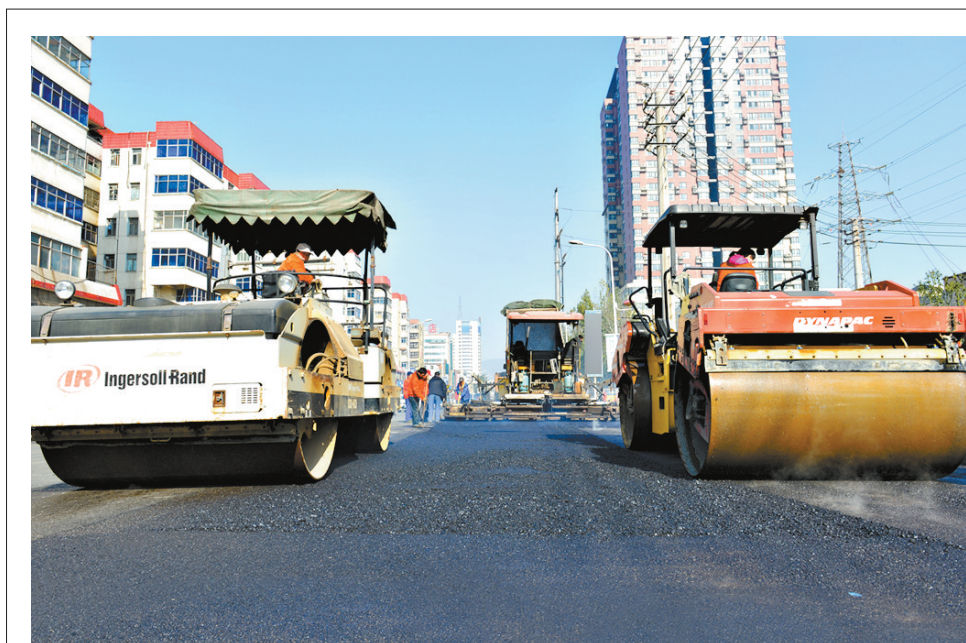
新华路南段改造 铺设沥青
