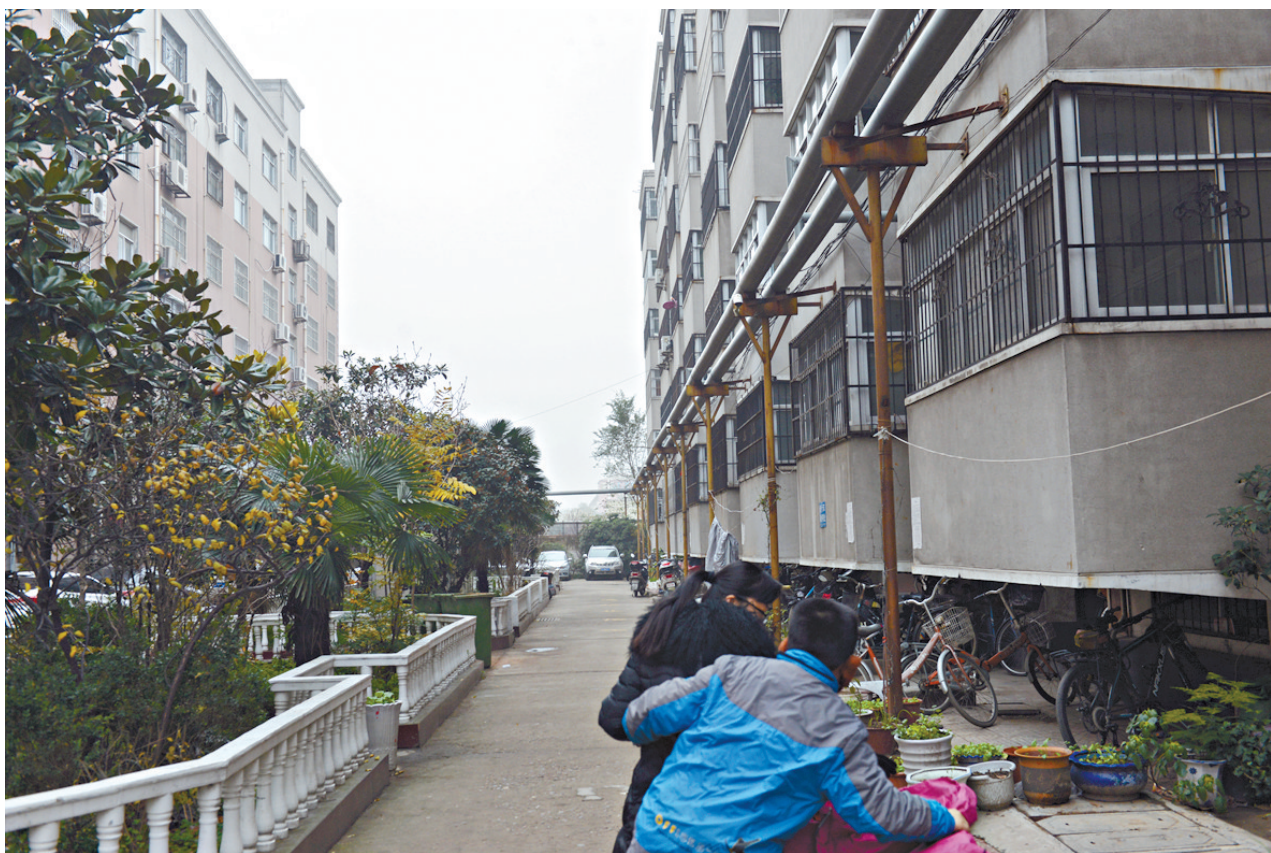
建移动宽带中转机房的园林路南14号院。 本报记者 彭程 摄
