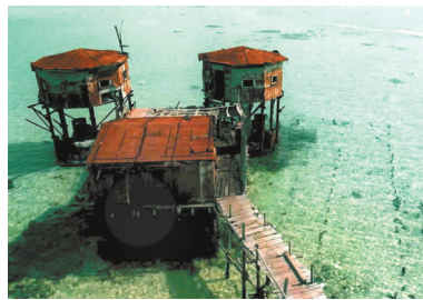
1989年初,守礁官兵住上了30平方米的第二代铁皮高脚屋,这种高脚屋以钢桩作柱,铁皮当墙。
