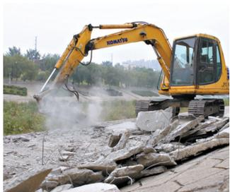
昨天,在市区文园路湛河桥西侧,挖掘机使用破碎锤在拆除排污暗涵上方的水泥层。
