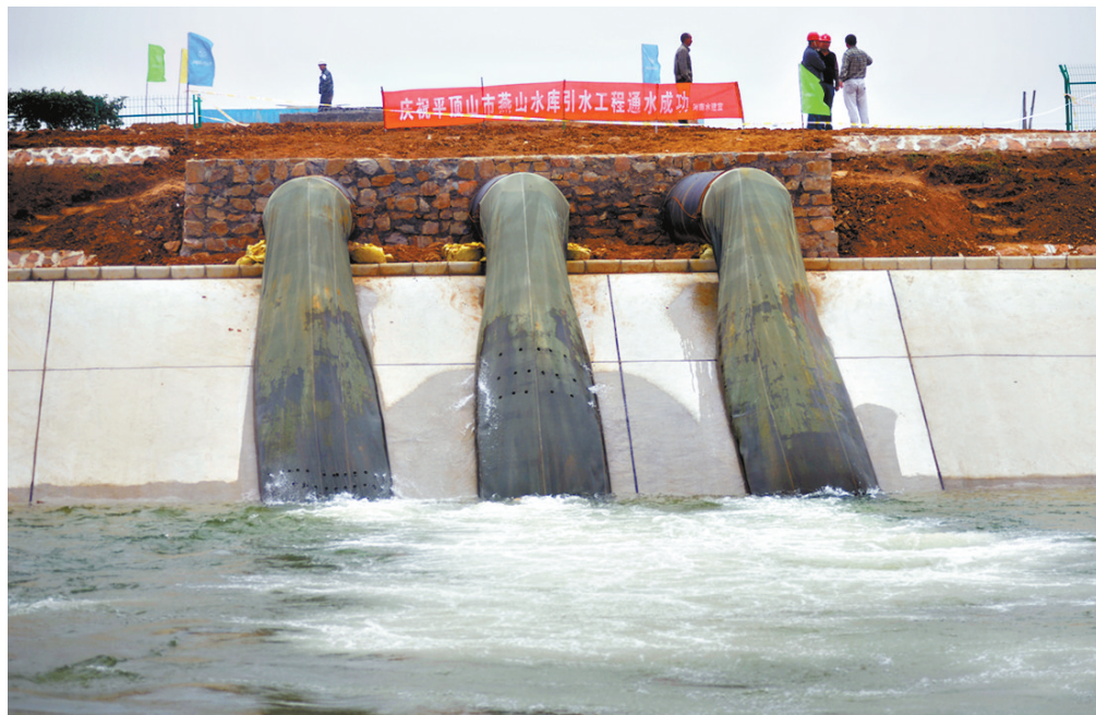
从燕山水库中引出的清水流入南水北调干渠。
