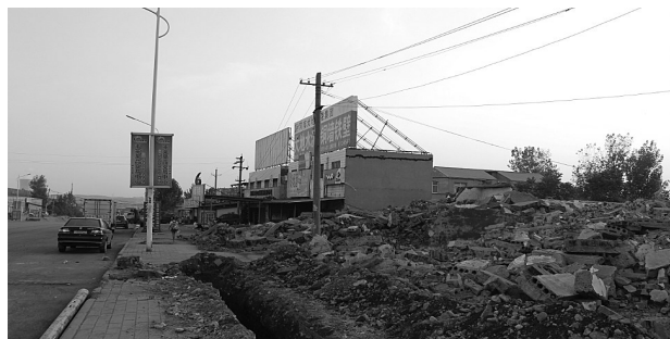
西延工程拆迁现场
