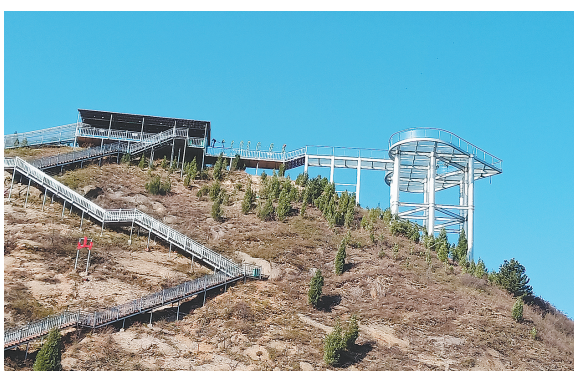
牛学勇在三门峡娘娘山景区承建的玻璃滑道项目
