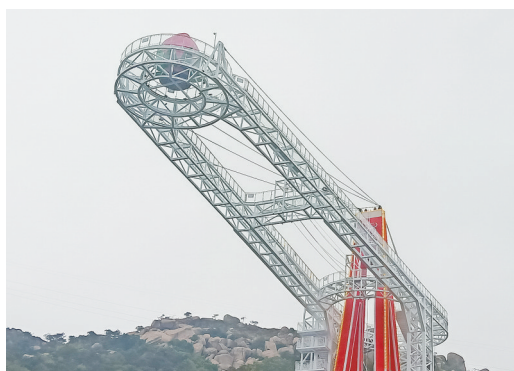
牛学勇在汕头市承建的斜拉玻璃观景悬廊
