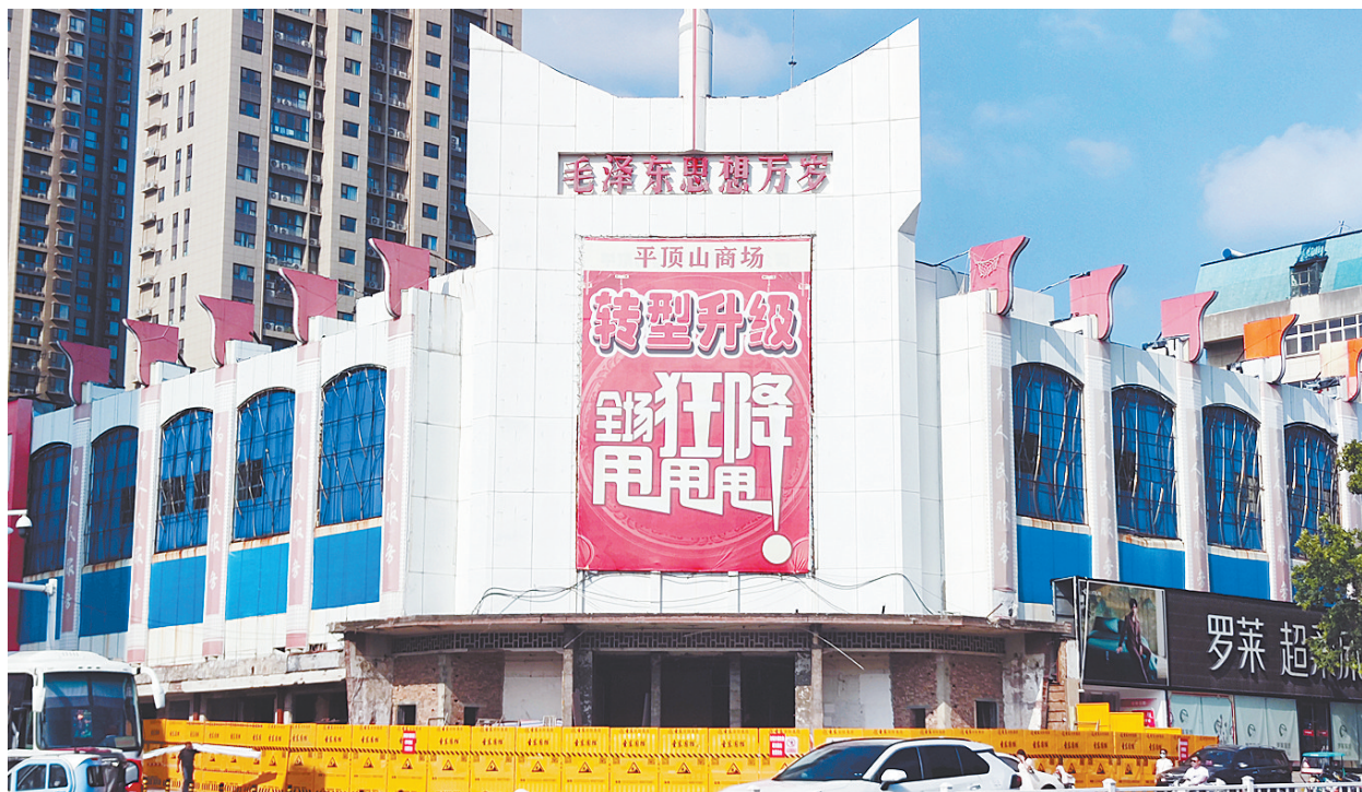
平顶山商场外竖起黄色围挡，正在升级改造
