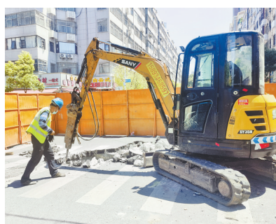
8月12日中午,施工人员在曙光街与体育路交叉口钻挖路面,查找空洞成因。
