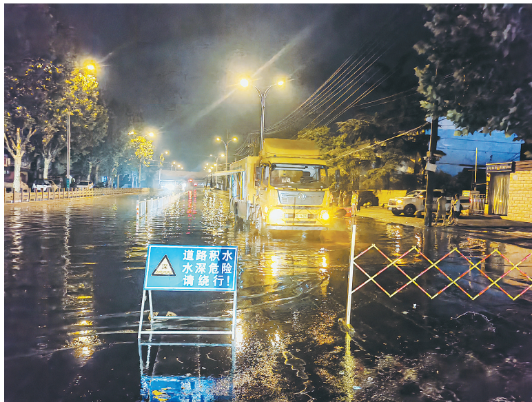
市城市管理局市政环卫事务中心工作人员对东环路平煤铁路桥附近的积水进行抽排。高星 摄
