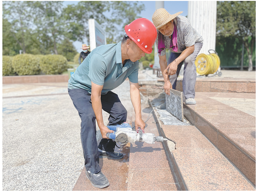
6月18日上午,鹰城广场欧式剧场内,施工人员揭下破损的台阶。
