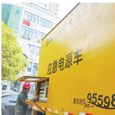
国网平顶山供电公司西城供电公司的工人在启动应急电源车
