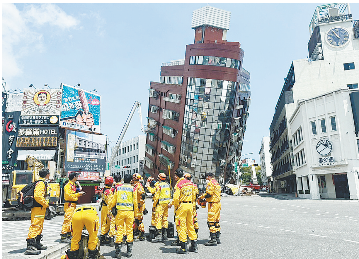
在花莲市,地震造成一栋大楼严重倾斜(4月3日摄)。新华社发
