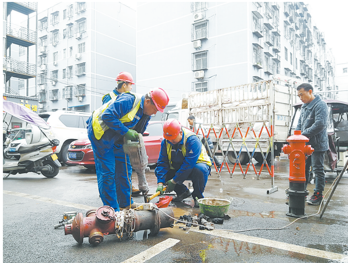
抢修人员更换坏掉的消防栓
