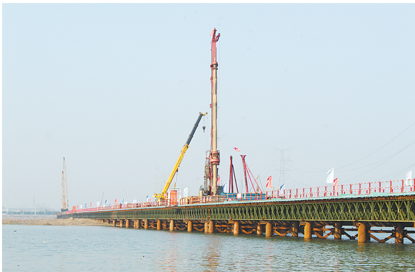
平漯周高铁站前二标项目鲁湛特大桥跨沙河钢栈桥顺利合龙。王靖鑫 摄
