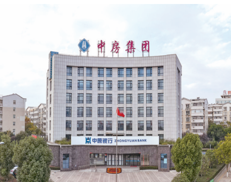
中房集团办公楼
