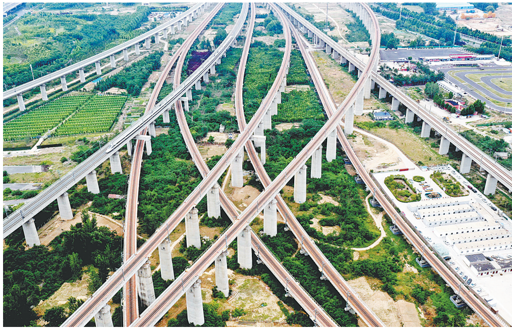
2024年5月30日拍摄的河南省郑州东站附近的高铁线路(无人机照片)。 新华社记者 李安 摄
