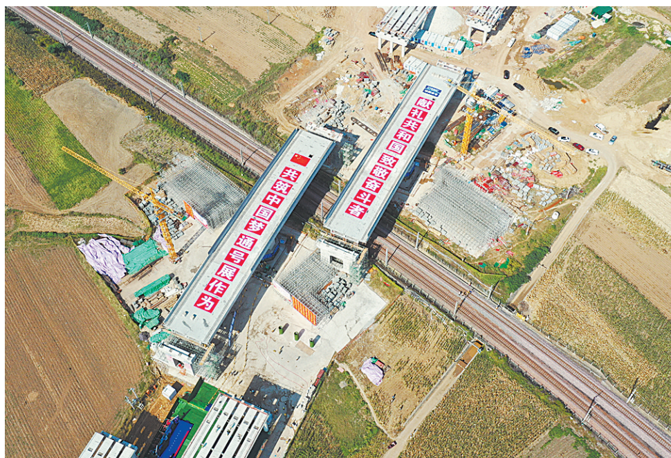
▲9月23日10时30分,焦唐高速公路汝方段上跨焦柳铁路立交桥成功转体。这是我市境内首次实施双幅桥转体施工。
