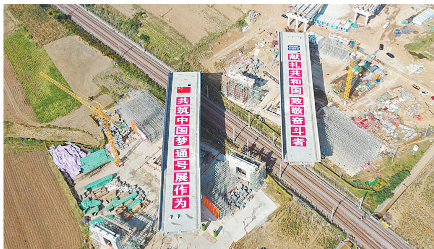
▲9月23日10时30分,焦唐高速公路汝方段上跨焦柳铁路立交桥成功转体。这是我市境内首次实施双幅桥转体施工。
