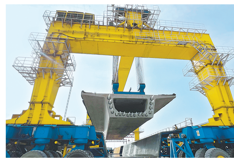
平漯周高铁漯河制梁场箱梁预制突破百榀
