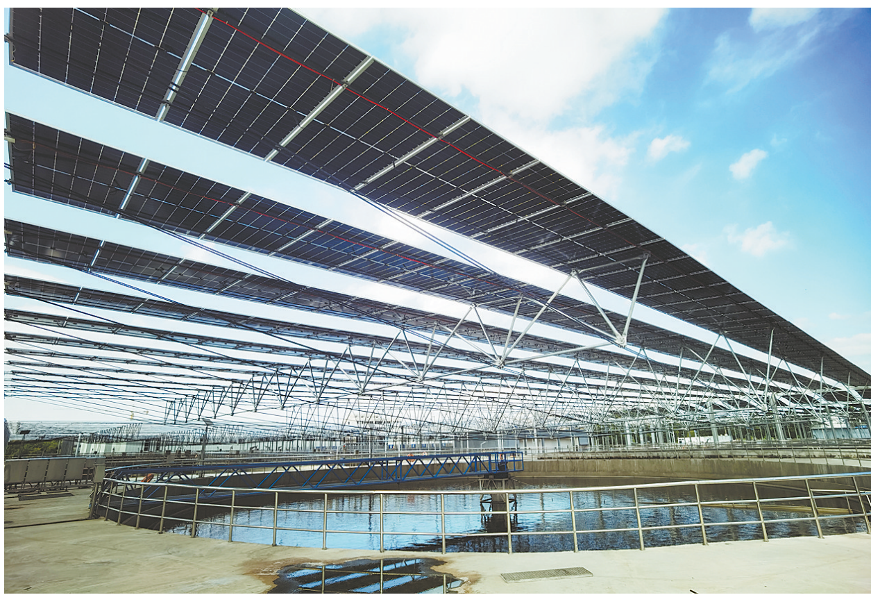
图为平顶山第三污水处理厂扩建项目一角
