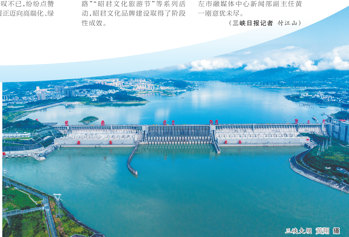
三峡大坝 黄翔 摄
