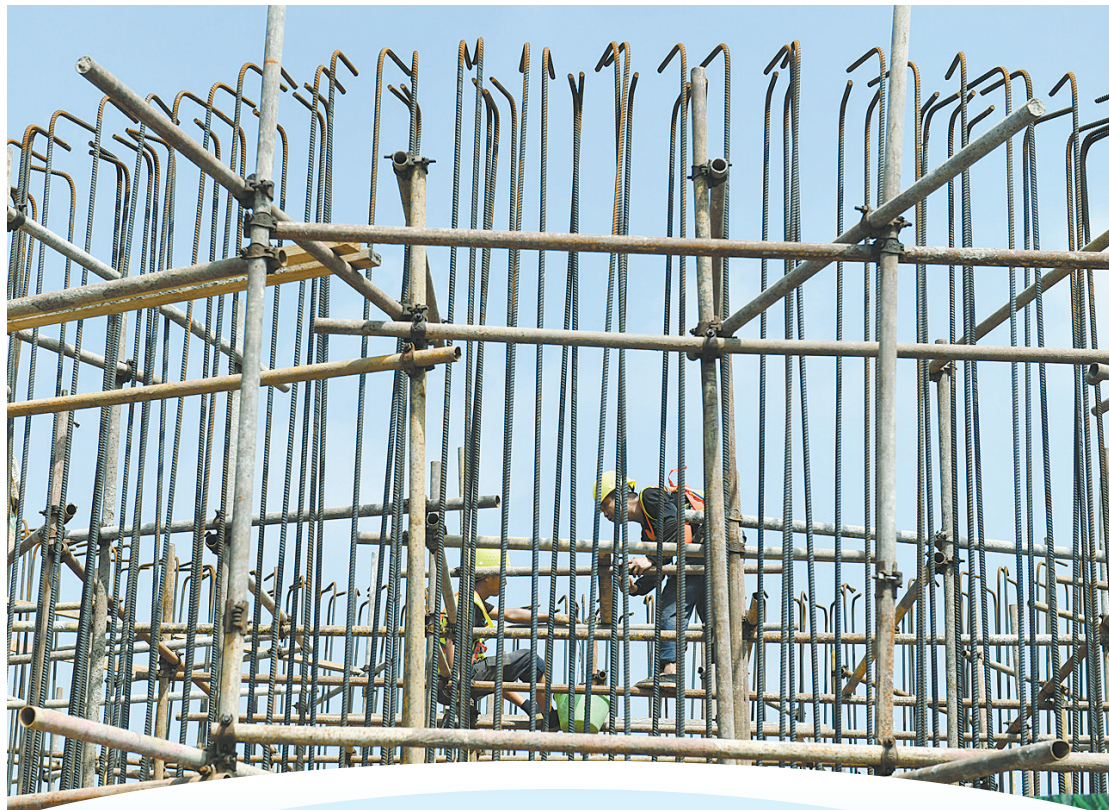
加快建设祥云河河道
