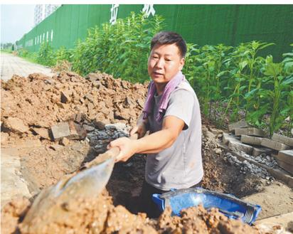
自来水管网维修工在开挖抢修漏水管
