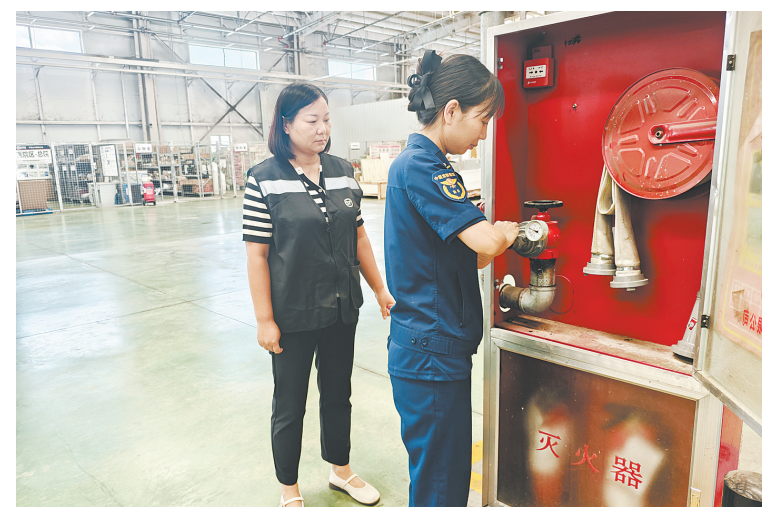
开展消防安全检查
