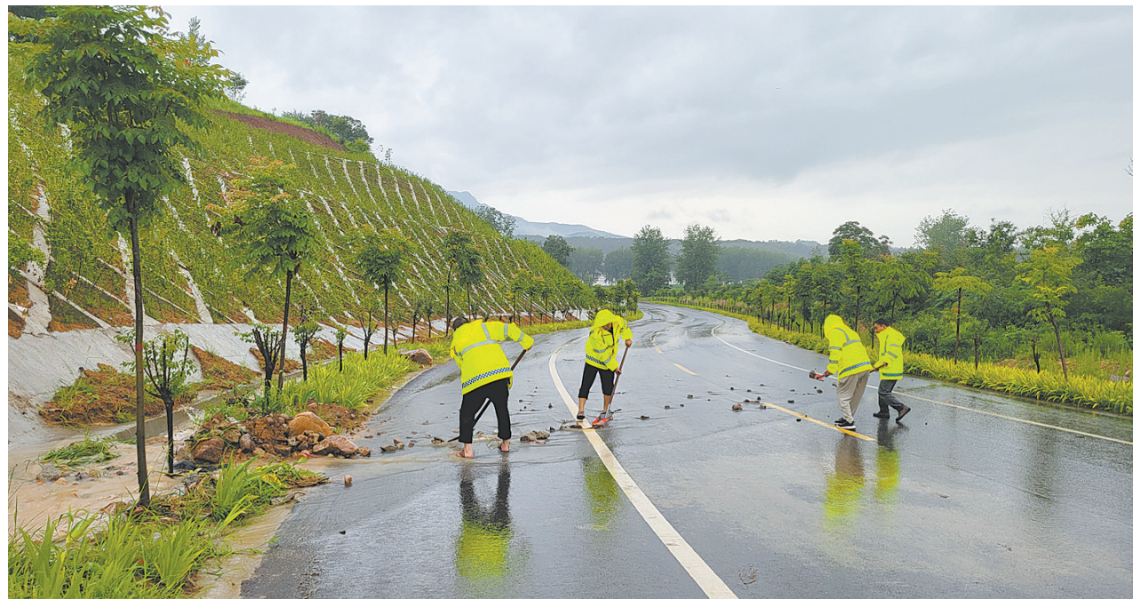
7月15日，舞钢市交通应急防汛工作人员在省道327一处路段清除积水（沙石路障）。7月14日至15日，舞钢市域内普降大雨，该市交通运输部门紧急行动，开展道路全线排查巡查、除险保通工作，确保群众车辆出行畅通安全。本报记者 杨德坤 摄
